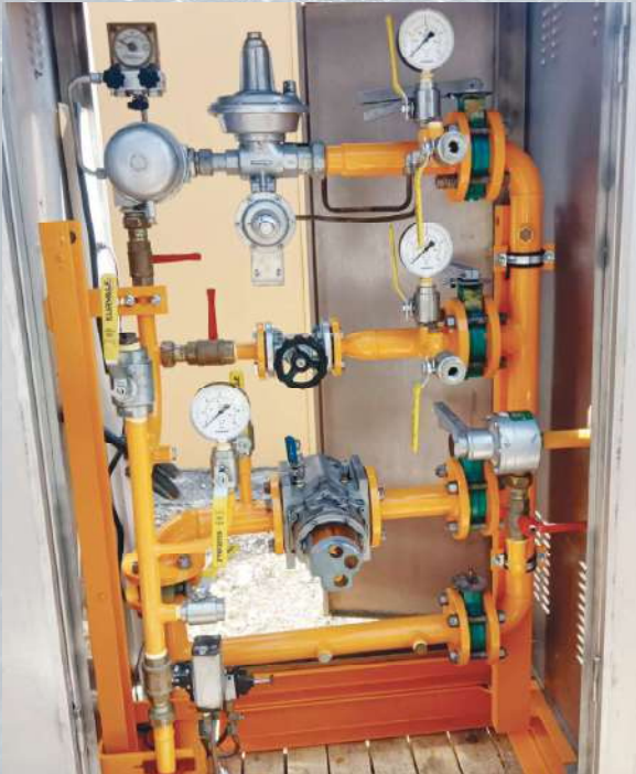
Müşteri Doğalgaz istasyonları bakım çalışmaları
