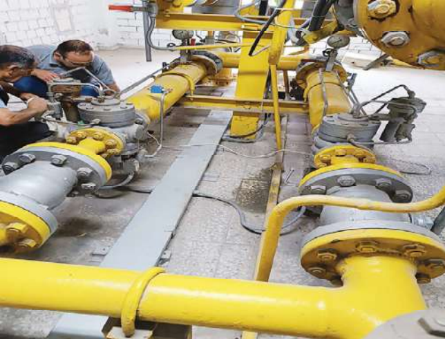
Doğalgaz istasyonları Regülatör bakım onarım çalışmalarımız (Doğalgaz ana istasyonları)
