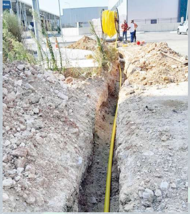
Doğalgaz alt yapı çalışmaları (Körüstan Sac Metal)
