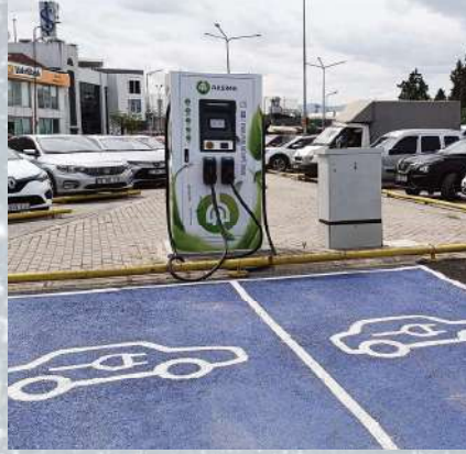
Sosyal Tesisler bahçesine 2 adet AC, 2 Adet DC olmak üzere toplam 4 adet elektrikli araç şarj istasyonu kurulumu tamamlanmıştır.
