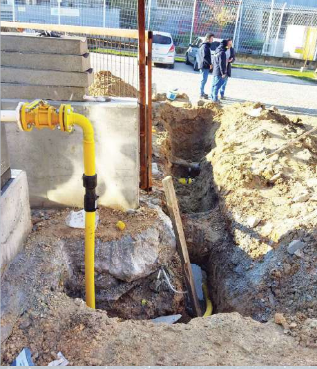
Yeni tesisler için bağlantı hattı yapımı ve doğalgaz istasyon montajı (Paktermo)
